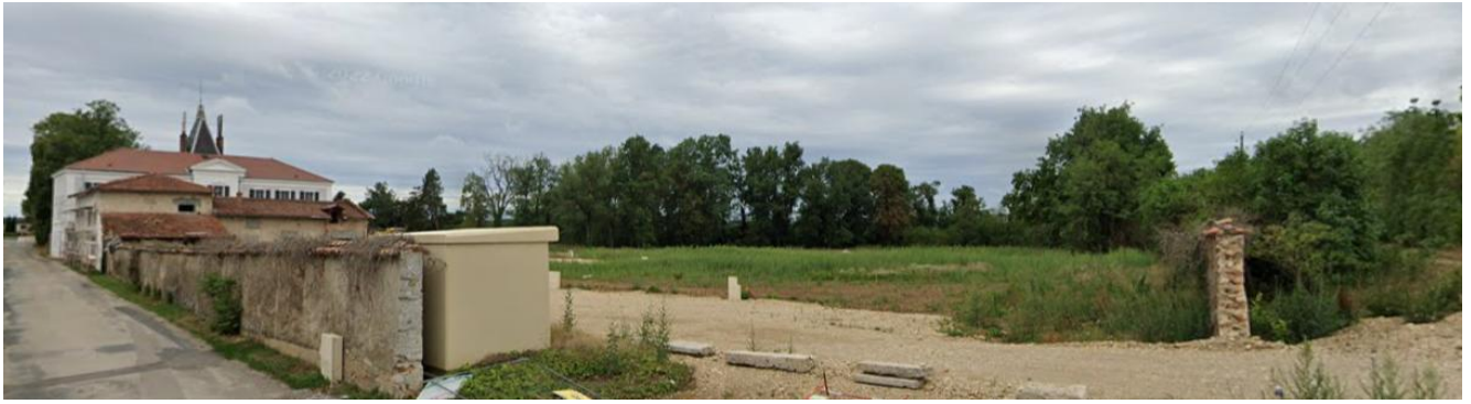
Travaux en cours en 2022
