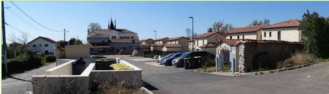
Zone UBe à l'issue de son aménagement avec le cône de vue préservé sur le château (avril 2025)
